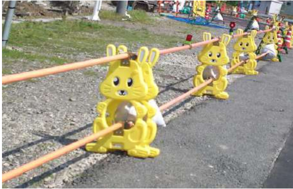
Abbildung 4: Absperrlinie auf einer Baustelle 9
